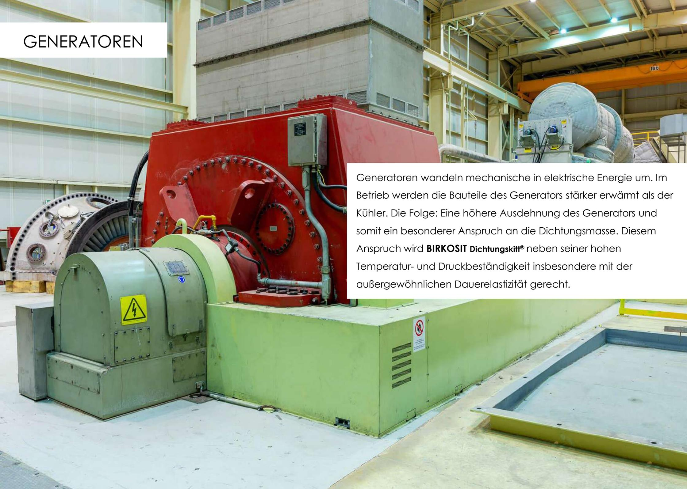
Generatoren wandeln mechanische in elektrische Energie um. Im Betrieb werden die Bauteile des Generators stärker erwärmt als der Kühler. Die Folge: Eine höhere Ausdehnung des Generators und somit ein besonderer Anspruch an die Dichtungsmasse. Diesem Anspruch wird **BIRKOSIT Dichtungskitt®** neben seiner hohen Temperatur- und Druckbeständigkeit insbesondere mit der außergewöhnlichen Dauerelastizität gerecht.
